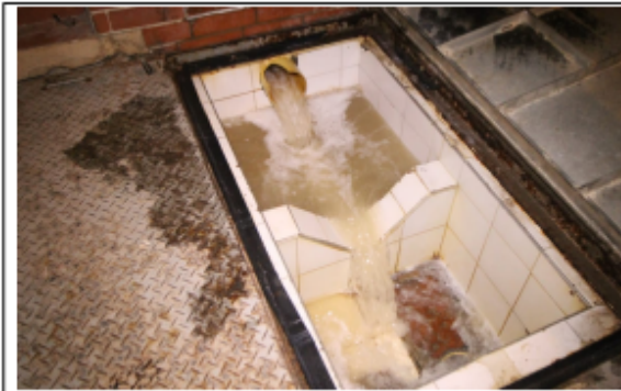
Fotografía 1. Caja de inspección externa
