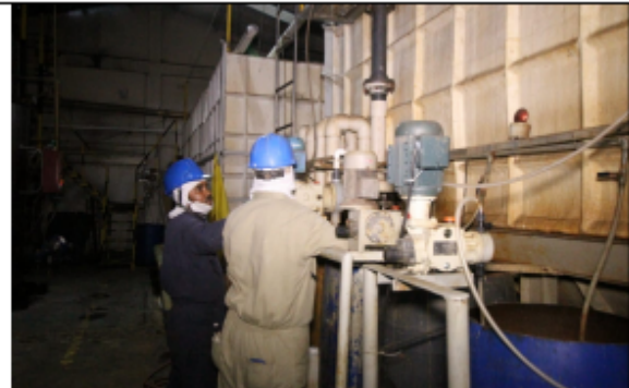
Fotografía 2. Planta de tratamiento
